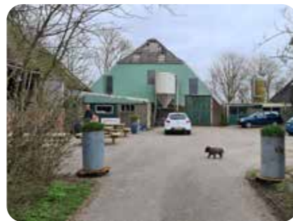
Binnenerf met winkel en vervallen stolpschuur
